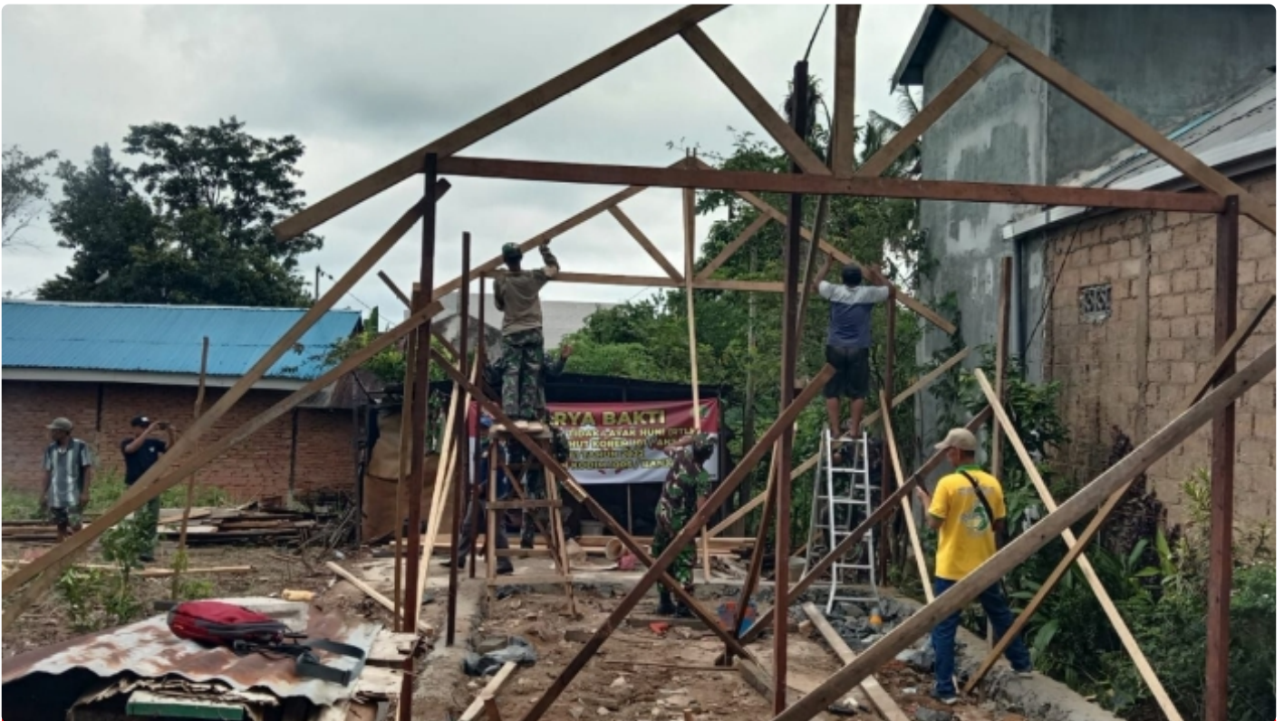
Setelah Dirobohkan " Kini Rumah Nursiah Dipasang Pondasi Dan Kuda - Kuda Rangka Rumah
